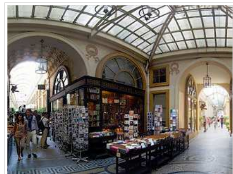
Exemple d'éclairage zénithal — Galerie Vivienne
